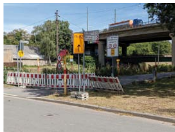
An den „Sutumer Brücken“ ist der Durchgang gesperrt, aber ein Mitarbeiter/Fahrer eines Energieversorgers meint: „Da hält sich eh keiner dran.“
