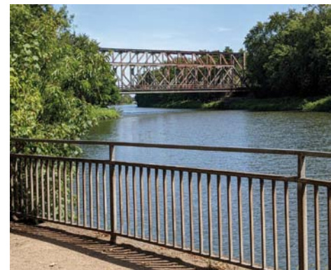
Hier ist es! Da die damalige Stelle durch das Fundament der Kurt-Schumacher-Brücke überbaut wurde, benutze ich eine ungefähre Position (Nordseite Kanal - Blickrichtung Bismarck - Wanne-Eickel)
