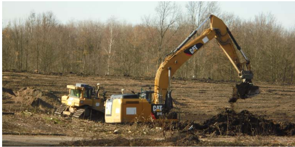
Um eine ehemalige Waldfläche nutzbar zu machen, reicht es nicht, nur die Bäume zu fällen, auch das Wurzelwerk muss aus dem Boden. Foto: Horst Wnuck
