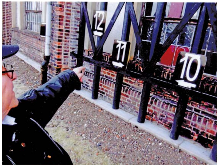
Für die jüngst eingezogenen Holzspaliere zur Abstützung der Unterzüge in den Fensternischen fand Paul Lindemann (links) als echter Bahnwerker schnell eine Umnutzung: Er brachte Schilder mit den Nummern der jeweils dahinter befindlichen Gleisstände an.
