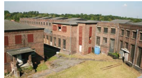
Das Bahnwerk ist eine weitläufige Anlage mit verschiedenen Gebäudeteilen, einige stehen komplett leer und werden mit Schutzblenden mehr schlecht als recht konserviert.
