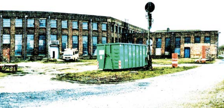
Imposantes Backsteinrund – das Bismarcker Bahnbetriebswerk aus den 1920er Jahren könnte ein regionaler Anziehungspunkt für Eisenbahn- und Technikfans sein, aktuell macht es aber eher durch Probleme auf sich aufmerksam.
