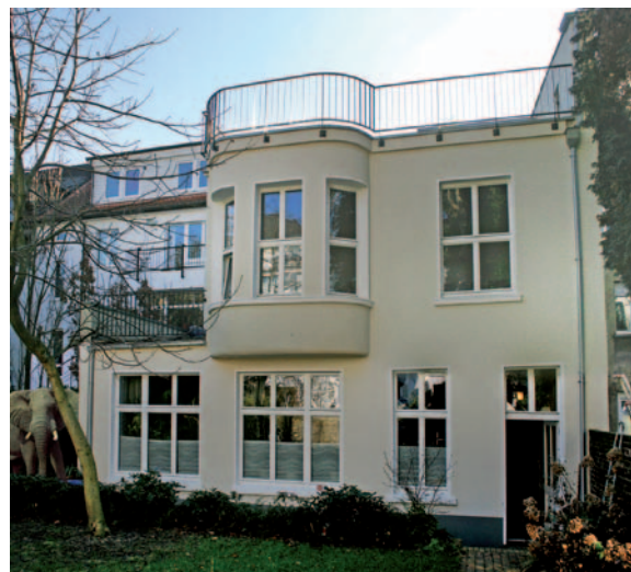
Das ungewöhnlich tief ins Grundstück ragende Haus in Rückansicht. Im kleinen Garten hat sich seit Franke's Zeiten wenig verändert.
