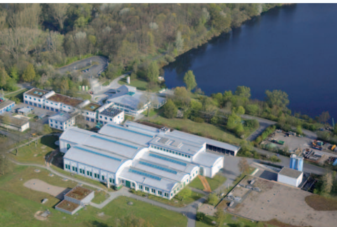
Das Wasserwerk in Haltern – von hier kommt das Leitungswasser nach Gelsenkirchener.
