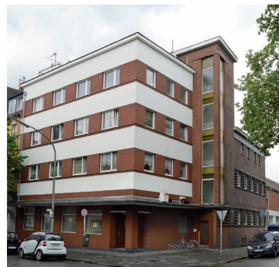
Das sogenannte „Kleine Hans-Sachs-Haus“ am Fersenbruch
